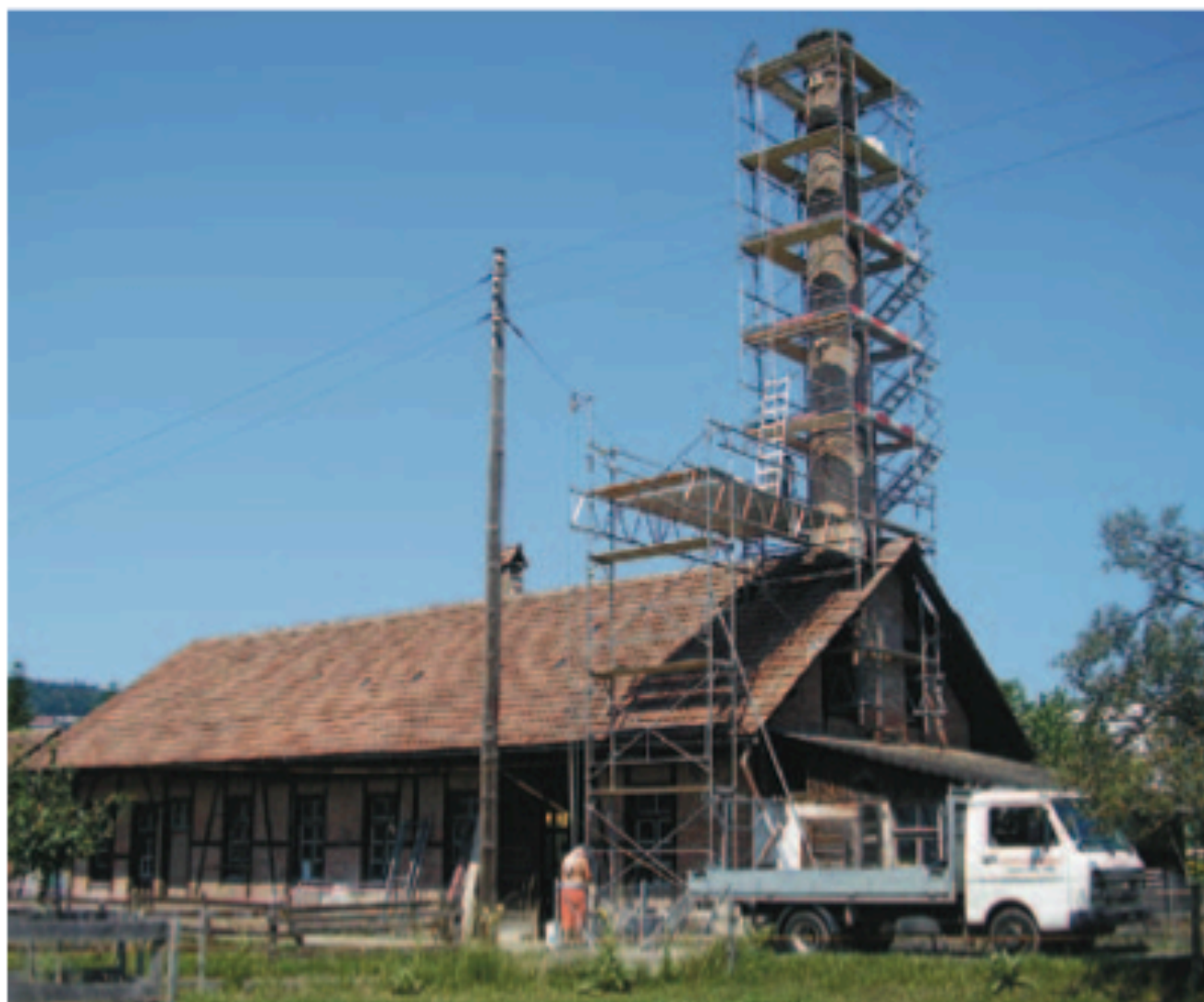
Der Kamin des «Fabriggli» ist für die Renovationsarbeiten eingerüstet.
